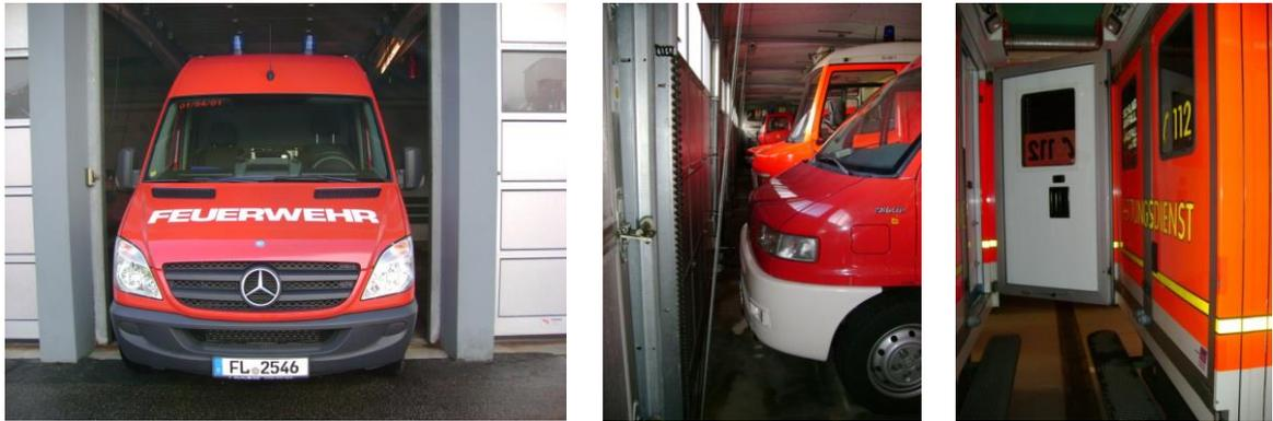
Abb. 86: Die Fahrzeughallen sind für die Einsatzfahrzeuge zu klein. Arbeitsschutzvorschriften können nicht eingehalten werden. (Fotos: Carsten Herzog)
